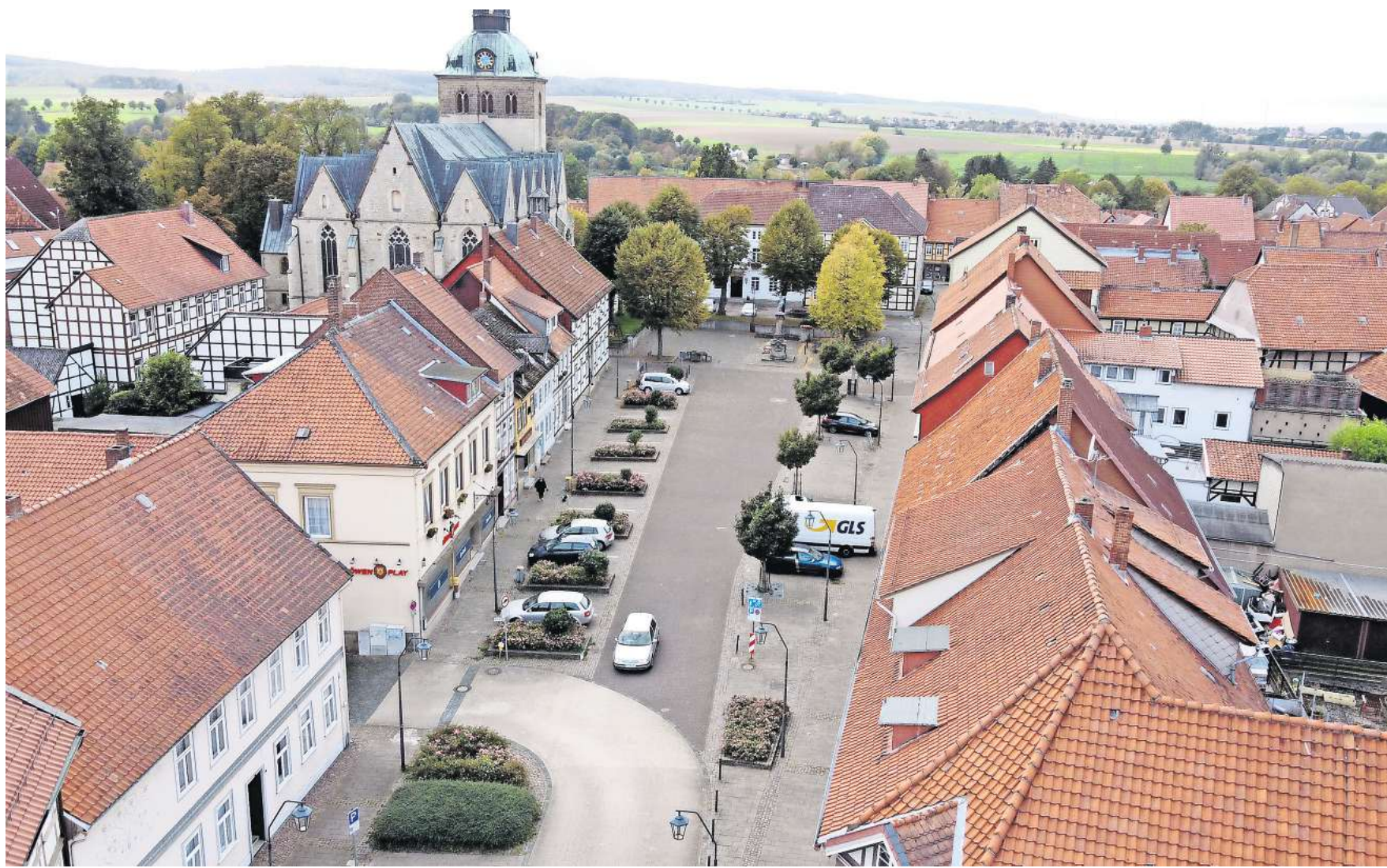
Bald beginnt die Umgestaltung des Buchholzmarktes. Die Bäume wurden bereits gefällt. Ende Mai rücken voraussichtlich die Bagger an.
